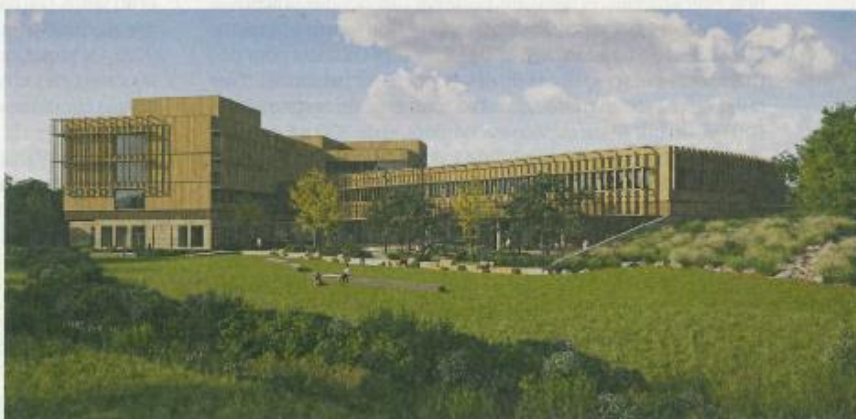
Le futur lycée de Vertou vise la certification HQE Bâtiment durable V4, niveau excellent, le label Bâtiment biosourcé niveau 3 et la labellisation Végétal local.
